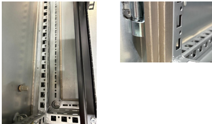
Afbeelding 5 – Afscherming met gaskets
